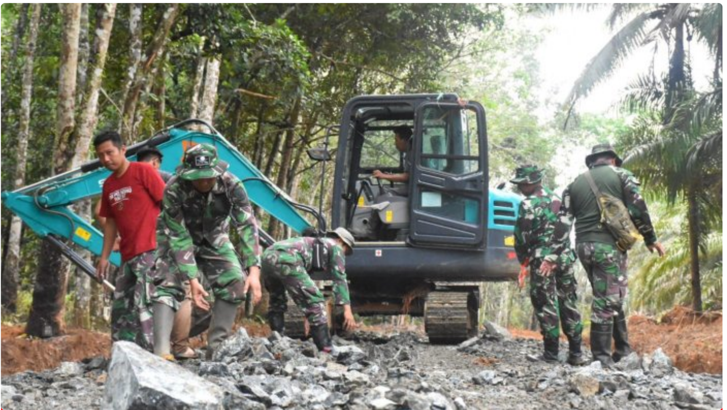
Semangat Satgas TMMD ke-116 Kodim 1004/Kotabaru Selesaikan Sasaran Jalan
